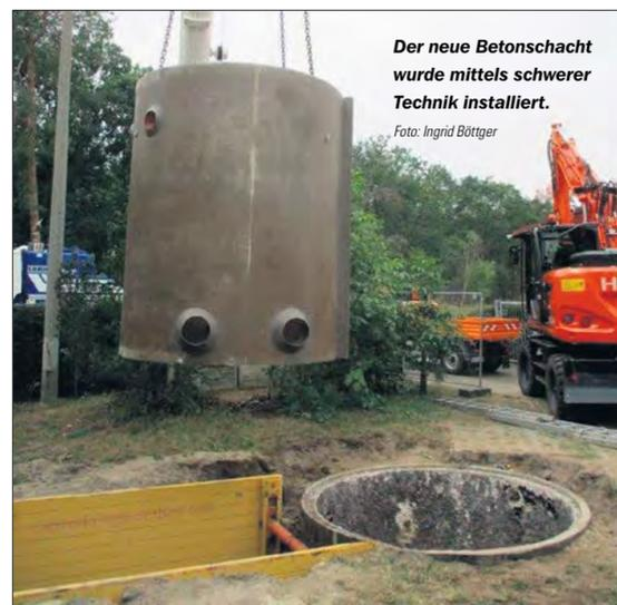
**Der neue Betonschacht wurde mittels schwerer Technik installiert.**
