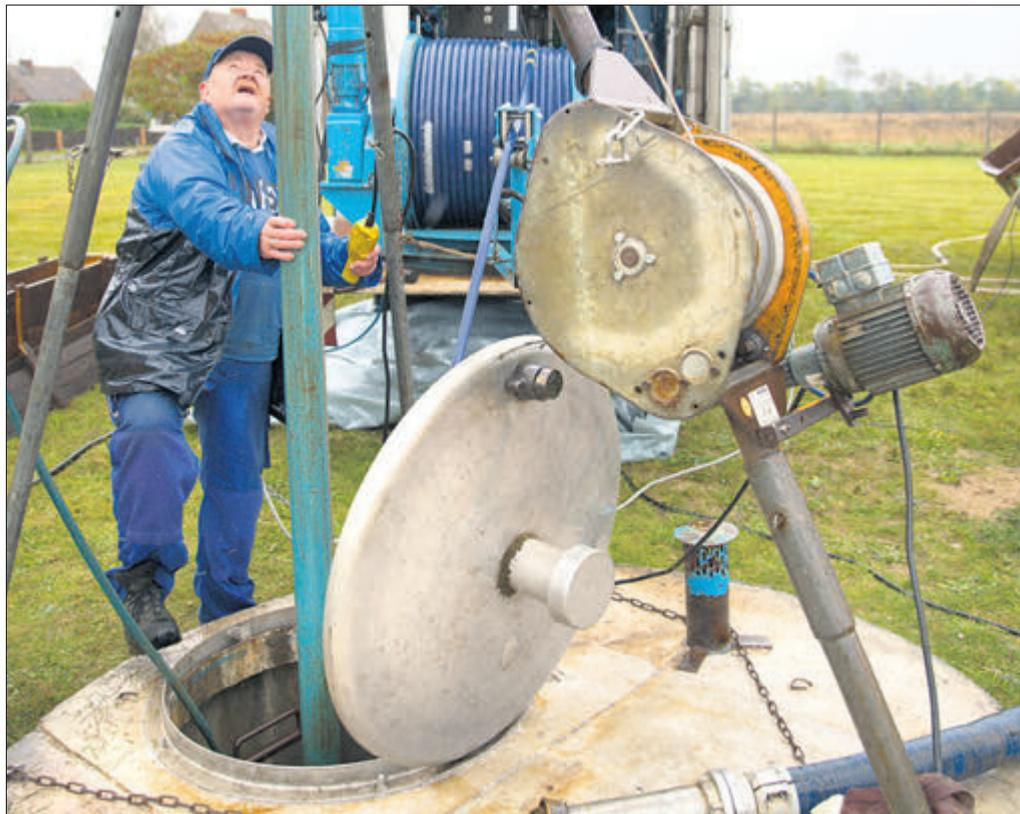
Der Blick nach oben führt anschließend in die Tiefe. Experten für Brunnenbau aus dem bayrischen Hof sorgten für die Regenerierung der Brunnen im Wasserwerk Mark Zwuschen.
