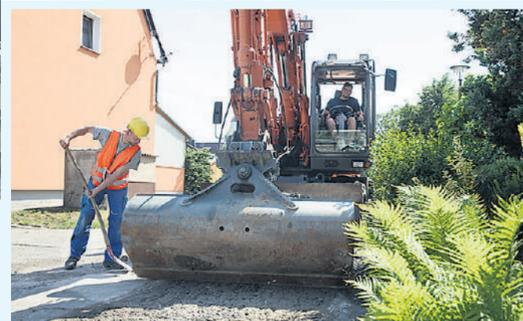
Mitarbeiter des WAZV verlegten anschließend die Leitungen und setzten Hausanschlüsse. Fotos (2): SPREE-PR/Gückel
