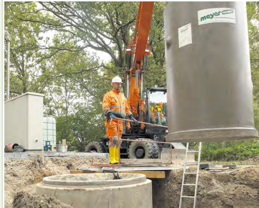
Vor dem Einbau neuer Pumpen und Rohrleitungen installierten die WAZV Mitarbeiter einen Schacht im Schacht, der das Innenleben künftig vor aggressiven chemischen Stoffen schützen soll.
