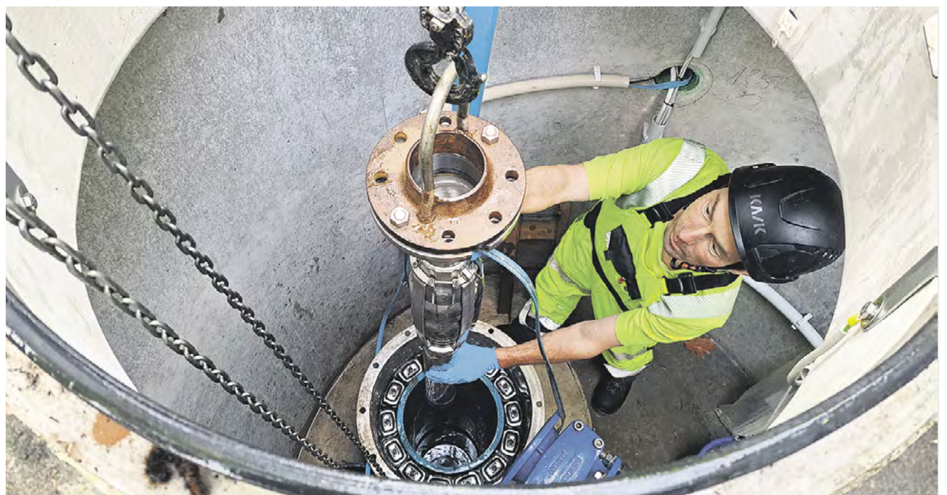
Stefan Krumbholz, Mitarbeiter des WAZV im Wasserwerk Jessen, nimmt das neue Leitungsrohr entgegen, um es fachgerecht in den Brunnen zu setzen.
