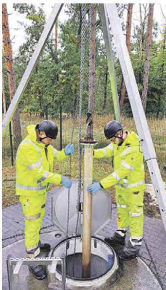
Meter um Meter wird das neue Leitungsrohr in den Brunnen geschoben. Die Sanierung garantiert dem Verband nun wieder mehrere Jahre sorgenfreies Arbeiten.
