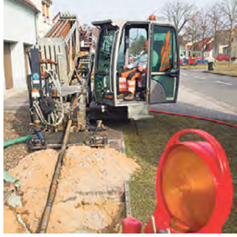
Soweit möglich, werden die Leitungen mittels moderner Verfahren verlegt.
