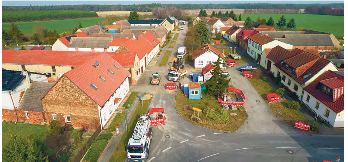
Der Blick aus der Vogelperspektive zeigt deutlich, dass in Leipa etwas im Gange ist. Noch bis zum Sommer soll hier unterirdisch alles auf den neuesten Stand gebracht werden.
