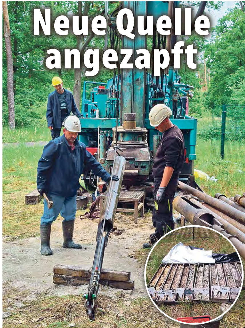
Mit schwerem Gerät drang die Bohrfirma in tiefere Erdschichten vor. Die einzelnen Sedimente ließen sich danach klar definieren (kleines Bild).
