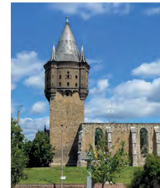
Der Wasserturm von Merseburg, Egeln und von Halle (Saale) sowie eine Veröffentlichung von Jens U. Schmidt (v. li. nach re.).
