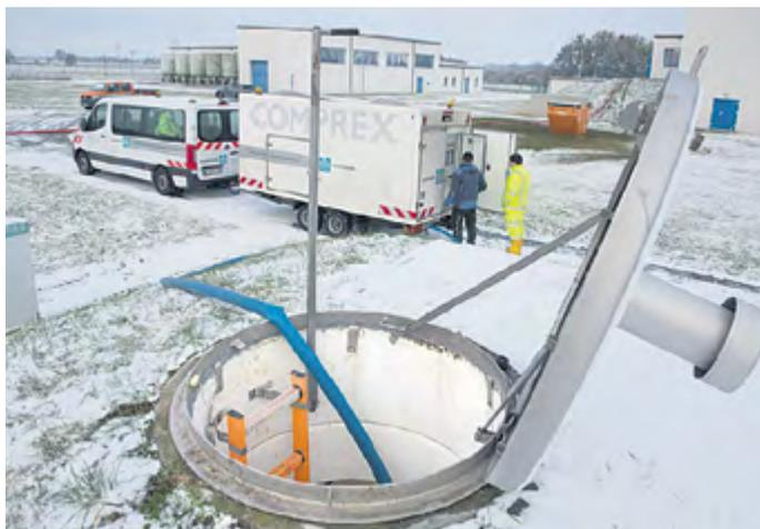
Mittels hohen Drucks wurden die Rohwasserleitungen gereinigt.
