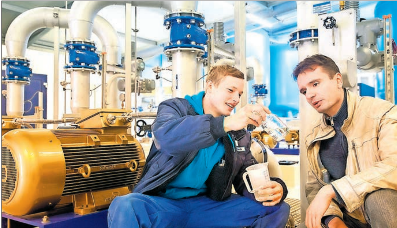
Zufrieden betrachten Wasserwerker Tim Hellbach (l.) und Bauleiter André Dippold eine Probe des im neuen Wasserwerk produzierten Trinkwassers.
