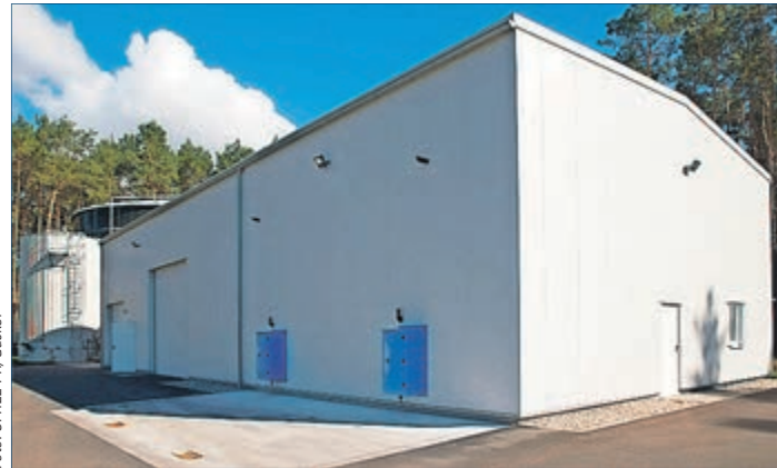
Innerhalb dieses Gebäudes werden die Abwässer der BMI vorgereinigt.
