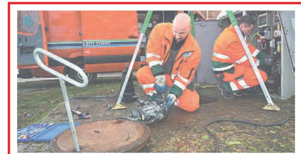
Der Wechsel einer Tauchpumpe im Abwasserschacht an der Alten Herzberger Straße machte sich in Jessen erforderlich. Ausgeführt wurde die Arbeit durch die WAZV-Mitarbeiter Tobias Witke (l.) und Ronny Zass. Die alte Pumpe war verschlissen und bereitete schon seit einiger Zeit Probleme, was sich unter anderem in unerwünschten Leitungsverstopfungen zeigte.
