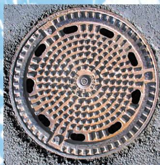
8. Einsteigschacht. Jeder Kanal hat etwa alle 60 m eine Öffnung nach oben. Durch diese Öffnung können Arbeiter einsteigen, den Kanal lüften, Reinigungsgeräte in den Kanal bringen, Verstopfungen beseitigen, Kanalschlamm entfernen.
