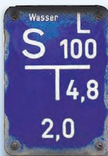
3. Das blaue Schild weist auf einen Absperrschieber für eine Trinkwasserleitung von 100 mm Durchmesser hin. Die Zahlen unter dem T geben wieder die Entfernung an: 4,8 m rechts und 2 m in gerader Richtung vor dem Schild. Das L bedeutet, dass der Schieber ein Linksgewinde hat.
