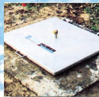
10. Schachtabdeckung aus Edelstahl, unter der sich technische wasserwirtschaftliche Anlagen befinden. Die Abdeckung darf nicht zugestellt oder gewaltsam geöffnet werden.
