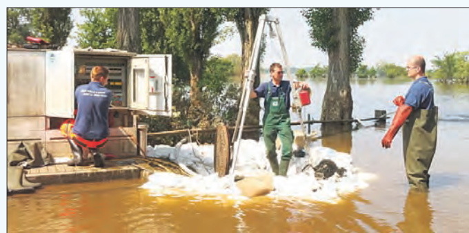
Mitarbeiter des WAZV bei Schadensbehebungen in Elster.
